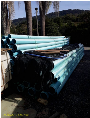
Foto 40 - Recomenda-se realizar o armazenamento adequado das tubulações no pátio da ETA.
