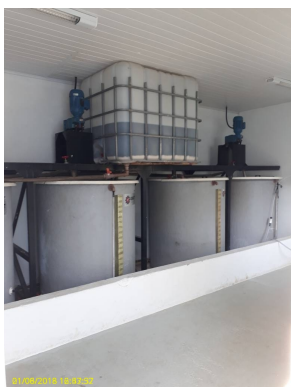
Foto 38 - É realizada dosagem de fluossilicato de sódio
