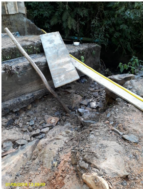
Foto 5 - Execução de canal extravasor
