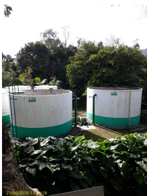
Foto 42 - 02 unidades em concreto armado de 50 m 3 cada.
