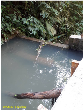
Foto 2 - Barragem de nível da captação
