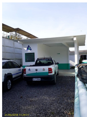
Foto 16 - Nova garagem para abrigo do veículo da CASAN..
