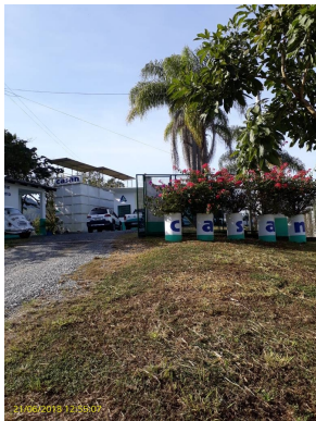
Foto 32 - Há cercamento na ETA.
