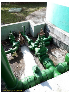
Foto 44 - As instalações foram devidamente pintadas.
