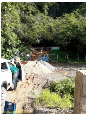
Foto 7 - Após as obras de melhoria será verificado se o local está devidamente cercado.
