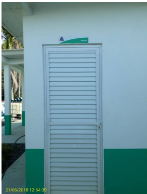
Foto 30 - Sala de produtos químicos.
