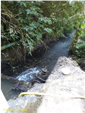
Foto 3 - Descarga de fundo da captação
