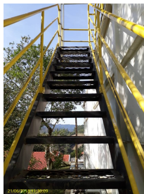
Foto 18 - Escada de acesso à ETA.
