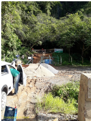
Foto 6 - O local está passando por obras de melhoria - após as obras será verificado se o portão está devidamente instalado.
