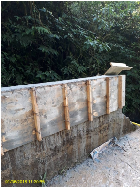
Foto 4 - Obras de melhoria - levantamento do nível de contenção para maior segurança e proteção das instalações da captação
